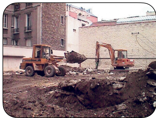
La cour de tennis en travaux, 1999
